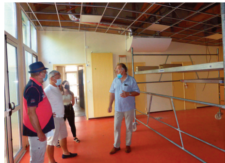
Le Maire en visite sur le chantier de l'école
