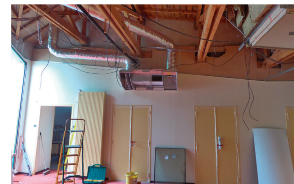
27 Juillet : installation des appareils de traitement de l'air en cours
