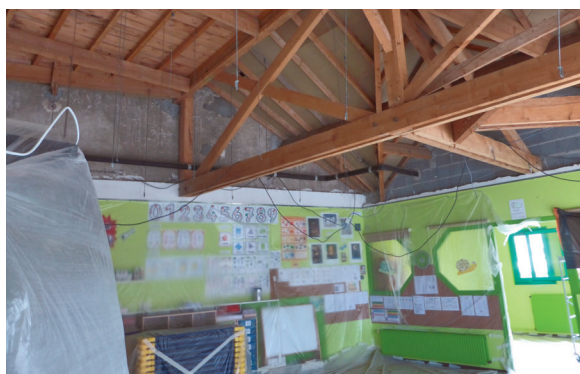
13 Juillet : chantier en maternelle
