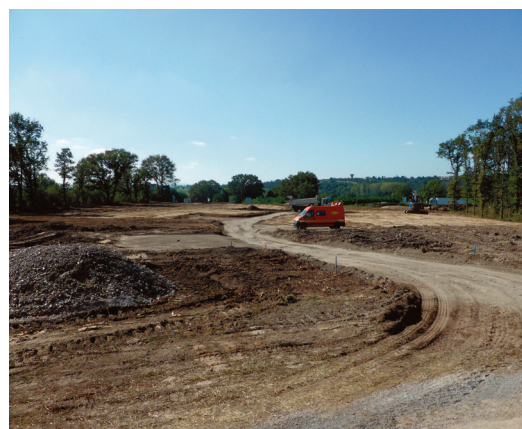
Les tous premiers travaux en Septembre 2021
