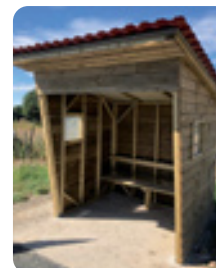
Mise en place d'un nouvel abri bus à Thizon
