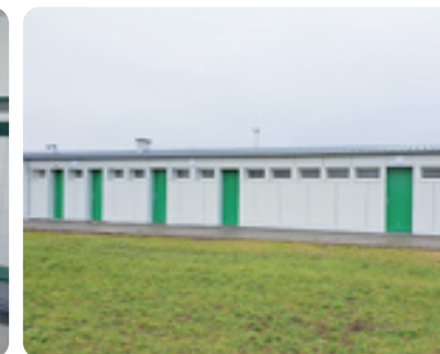
L'ancien vestiaire rénové, bardage extérieur et tribune
