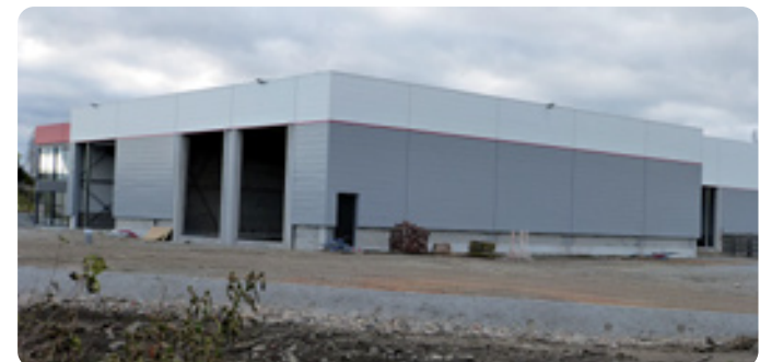
Renault Trucks - Atelier en cours de construction
