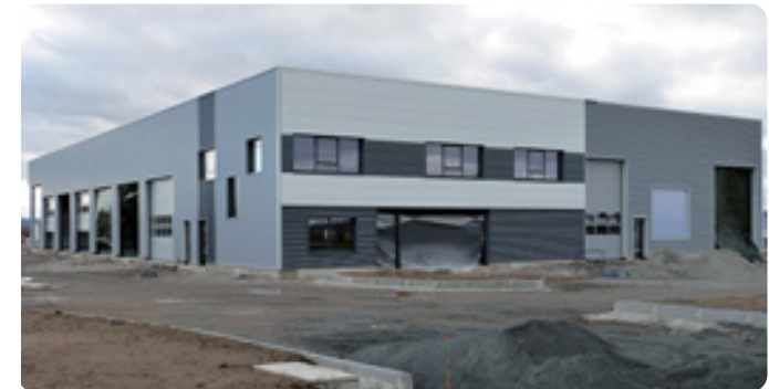
CIGAM V.I. - Atelier en cours de construction
