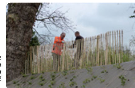
Pose d'une clôture séparative en haut du talus du parvis de la Maison de Santé
