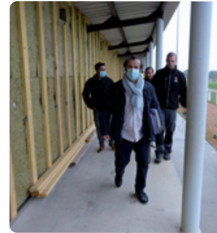
Suivi des travaux au stade
