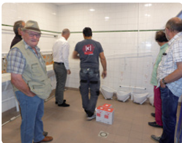
Réfection des sanitaires de l'école
