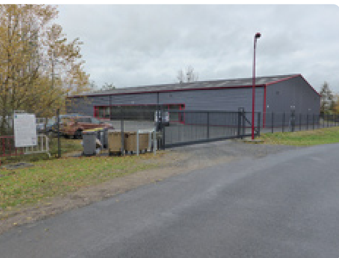
Nouveaux locaux des services techniques
