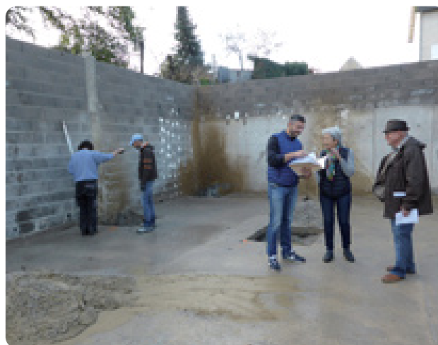
Suivi de chantier de la maison de santé
