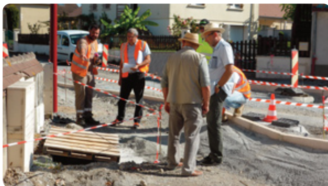
Chantier du bourg
