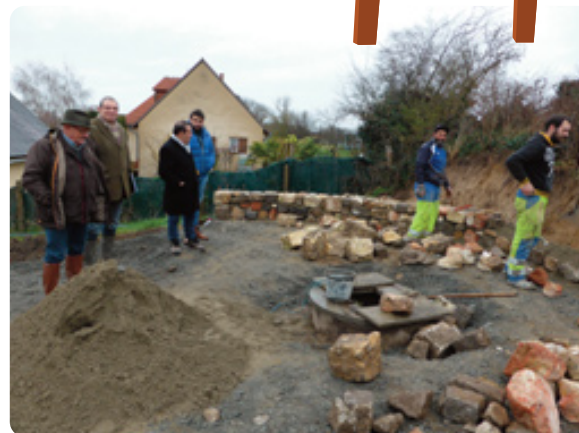
Le Verger paysager en chantier
